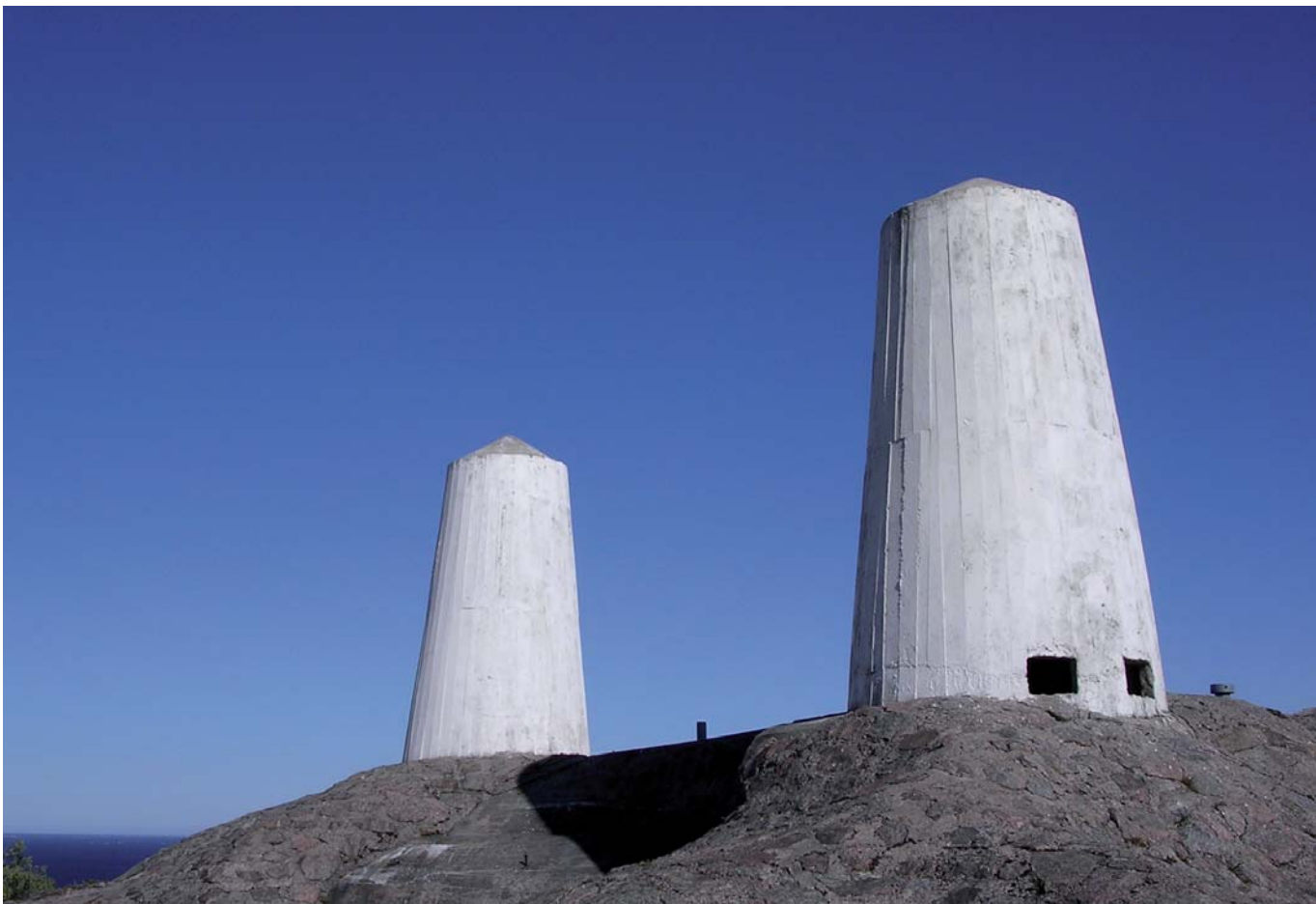
Hellesundsvardene omtales av Peder Claussøn Friis rundt 1600. De to opprinnelige steinvardene ble fjernet av tyskerne under andre verdenskrig, men nye betongvarde ble reist etter krigen. De to vardene pryder kommunevåpenet i Søgne. Foto: Gunnar Eikli
